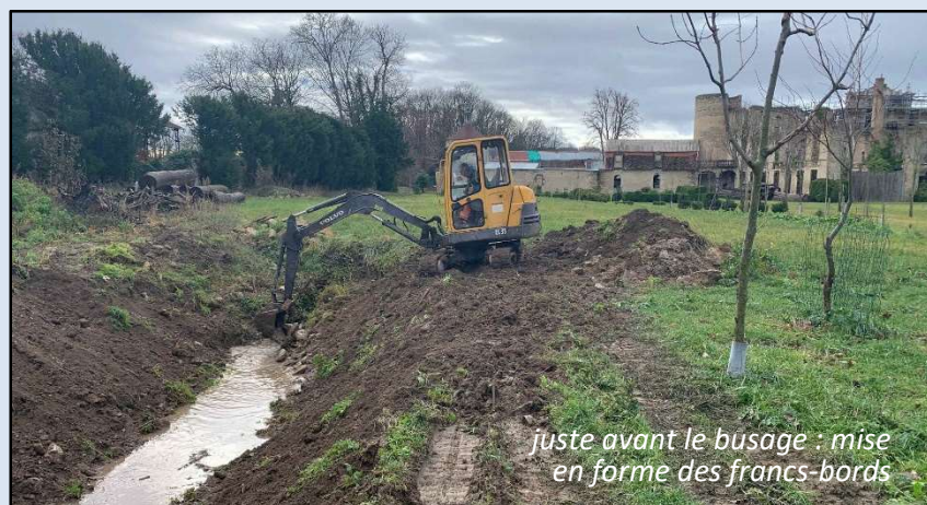
vérification visuelle de la pente
