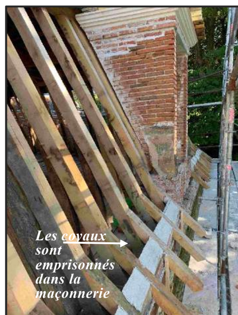
En cours de réalisation : le terrasson (partie supérieure est terminée, les chevrons du brisis sont en place et attendent la volige.
