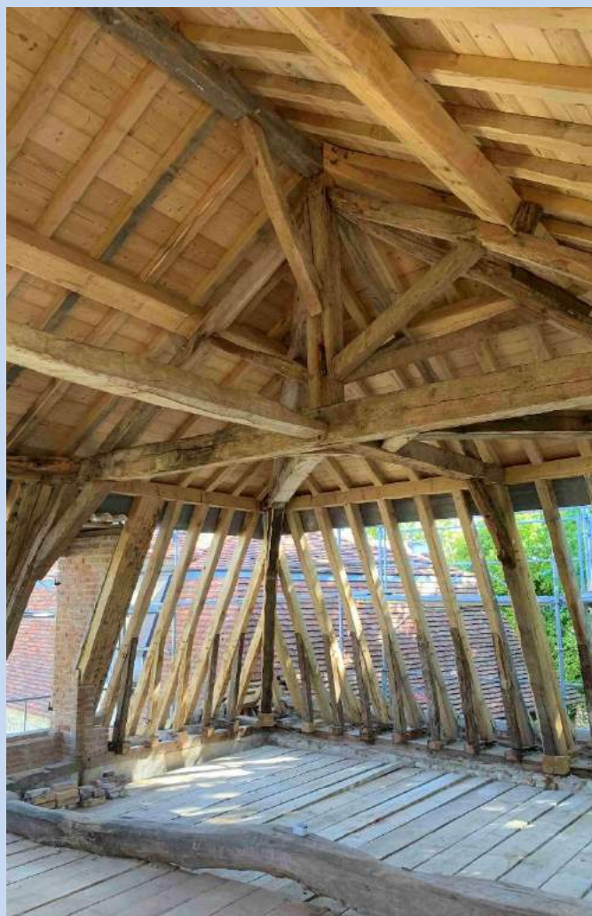
(Vue de la charpente en cours de réfection par l'entreprise Maurice NAILLER : le plancher de travail que l'on aperçoit est un platelage provisoire, situé à 4,00 m de hauteur, pour faciliter le travail des charpentiers)
