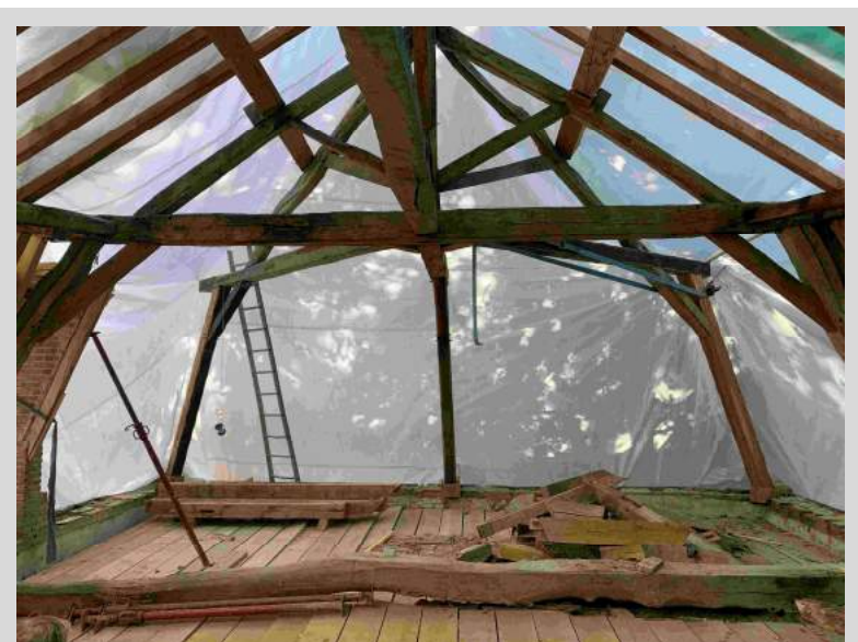
(Ci-dessus : vue de la croupe après démolition complète du travail précédent. Mise en place des 3 arbalétriers.)
