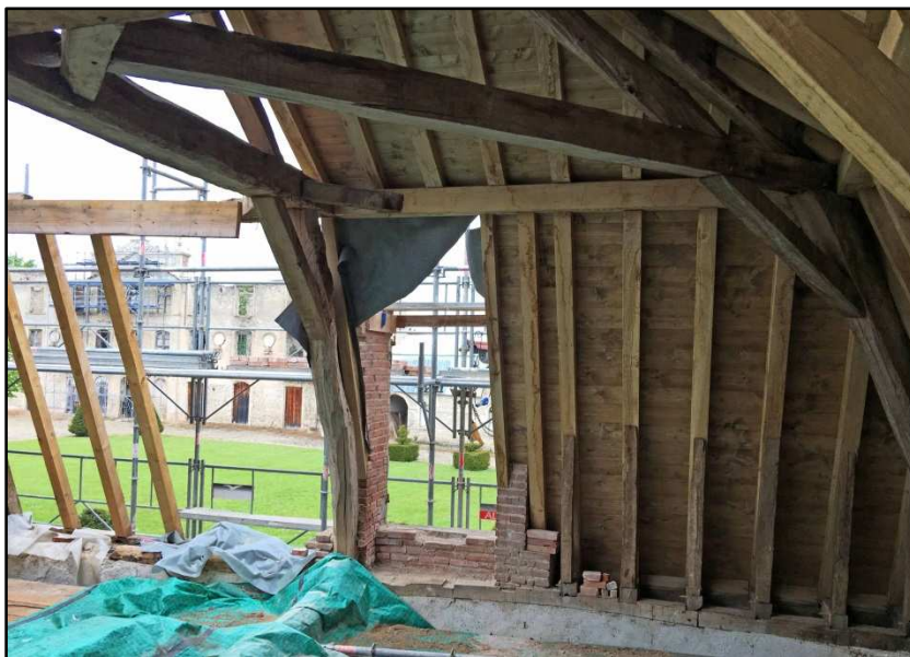
en partie haute, : entrail, poinçon, jambes de force et pannes anciennes sont conservées
