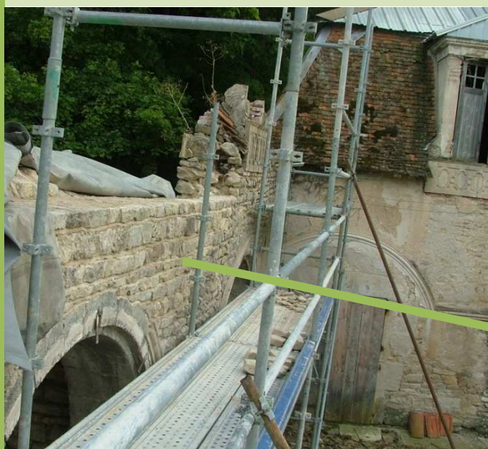
vu des têtes de mur en cours de reconstruction
