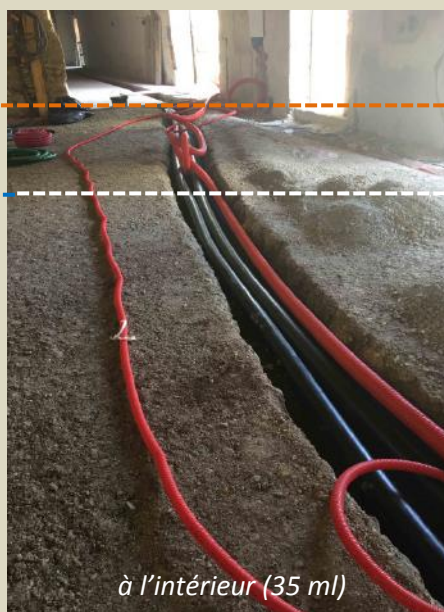
passage des tuyauteries de part en part de la grange
