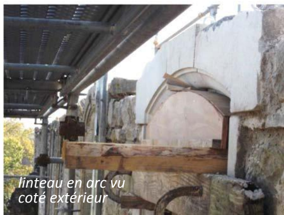
linteau en arc vu du côté intérieur du bâtiment
