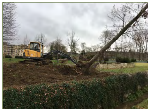
Une fois le trou réalisé, dernière phase : basculement de l'arbre déraciné.
