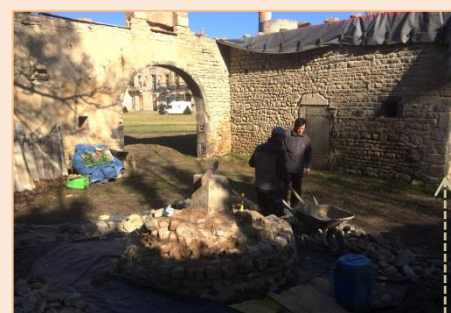
angle de la partie maçonnée
