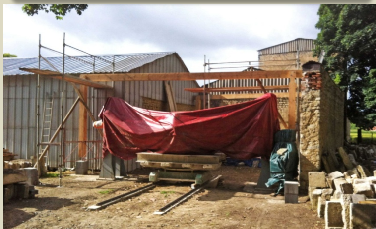
Scie à eau (bâchée) en place et ossature en cours
