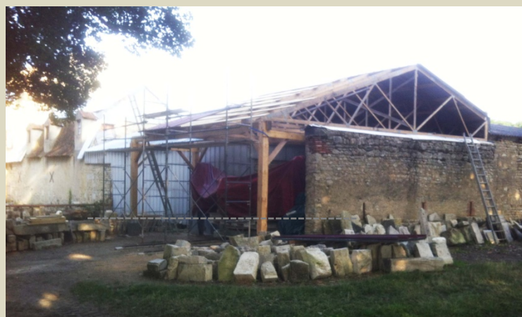
Finition de charpente/couverture
