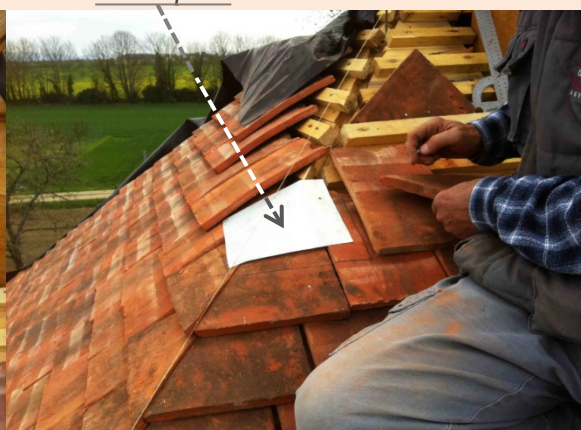
les noquets en zinc assurent l'étanchéité
