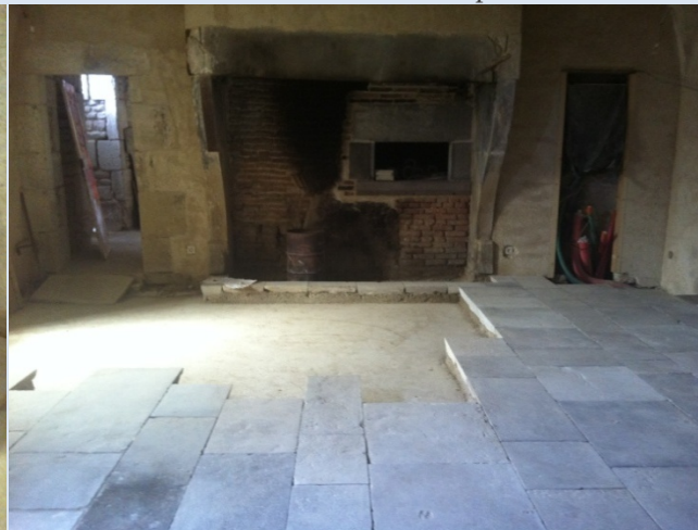
autre vue en cours de pose
