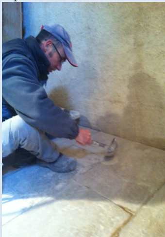
coulage des joints
