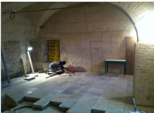
aspect en cours de travaux
