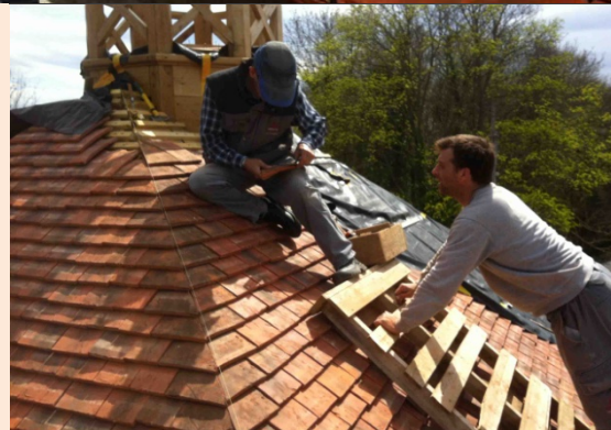
les noquets en zinc assurent l'étanchéité
