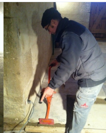
pose d'une dalle
